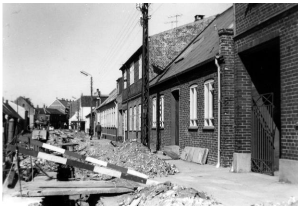
I foråret 1962 kom fjernvarmen til Østergade – og til Østergade 33.
